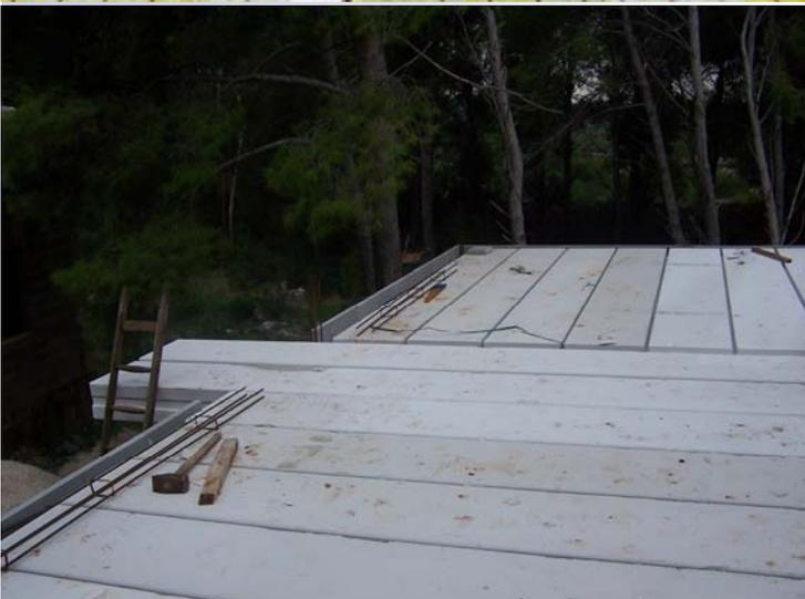
Вместе с тем долговечность крыши гарантирована. Междуэтажное перекрытие верхнего этажа изготовлялось как готовый потолок в Германии.
