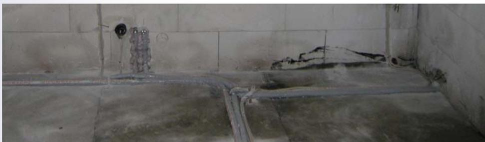
Водопроводы и сточные воды изолированы от конденсации.
