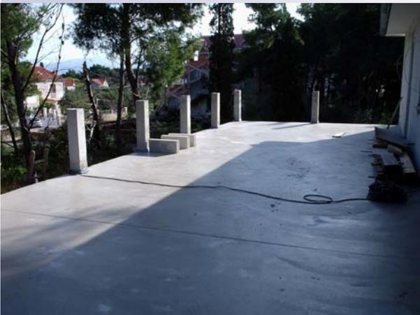
Построенный на вечность: Основание залито примерно 130 м<sup>3</sup> бетона и укреплен двумя слоями арматуры на мраморной земле Брача.
