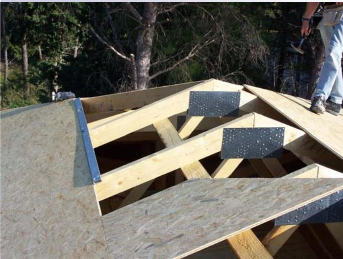
Крыша полностью обложена плитами OSB, которая даёт защиту при возможных штормах.
